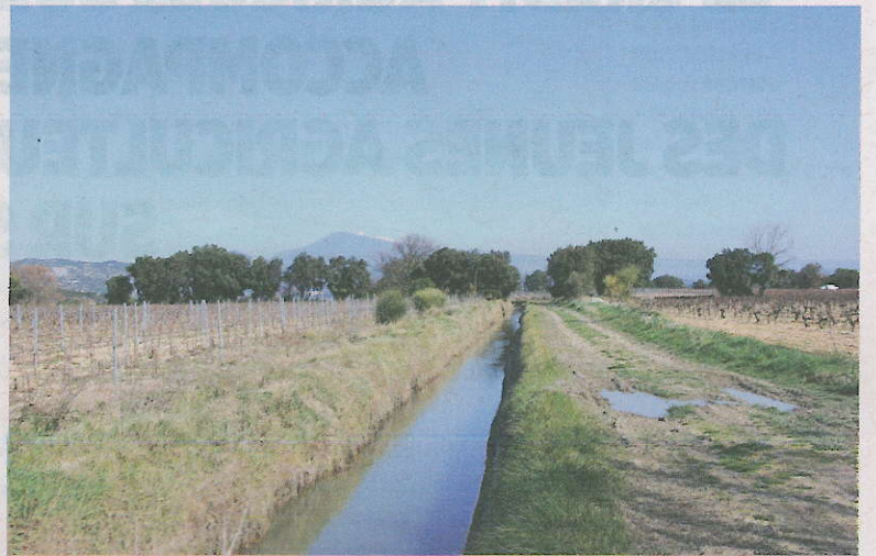
Six associations syndicales autorisées (ASA) du territoire HPR, dont deux drômoises, ont déjà lancé des projets de conversion de leurs réseaux gravitaires vers des réseaux sous pression. © Bertrand Saugues.
