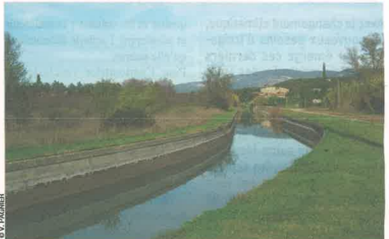
Pour le projet 'Hauts de Provence Rhodanienne', le périmètre concerné s'étend sur 85 000 hectares de terres agricoles, dont 40 à 50% peuvent être irrigués, soit entre 30 000 et 40 000 ha.
