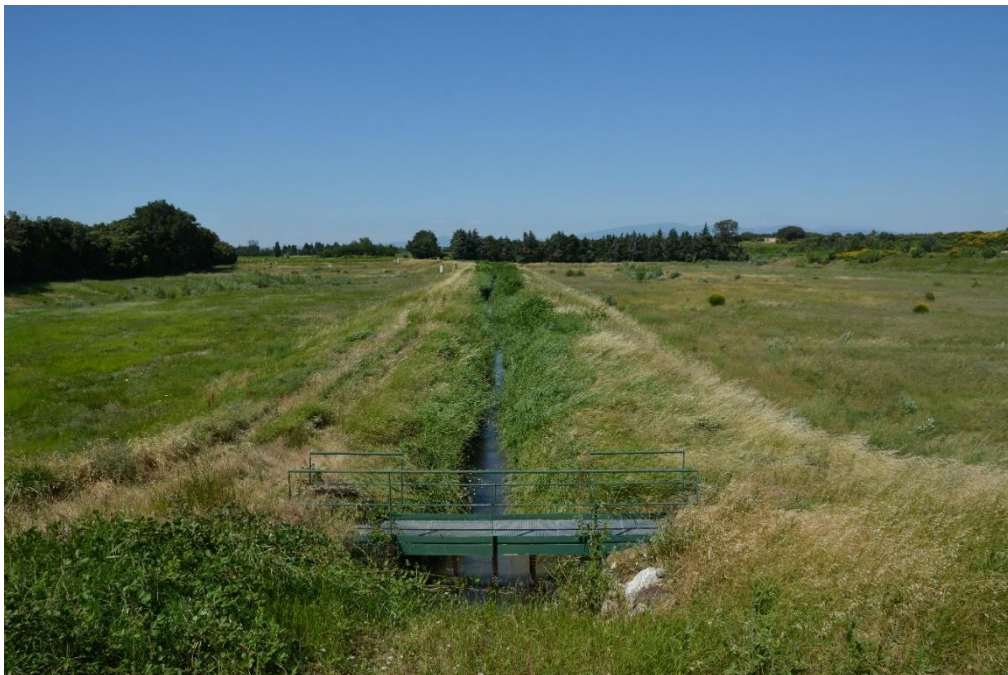
Figure 16 : Bassin de rétention de crues en tête du périmètre de l'ASCO d'entretien et d'aménagement hydraulique Sérignanais
