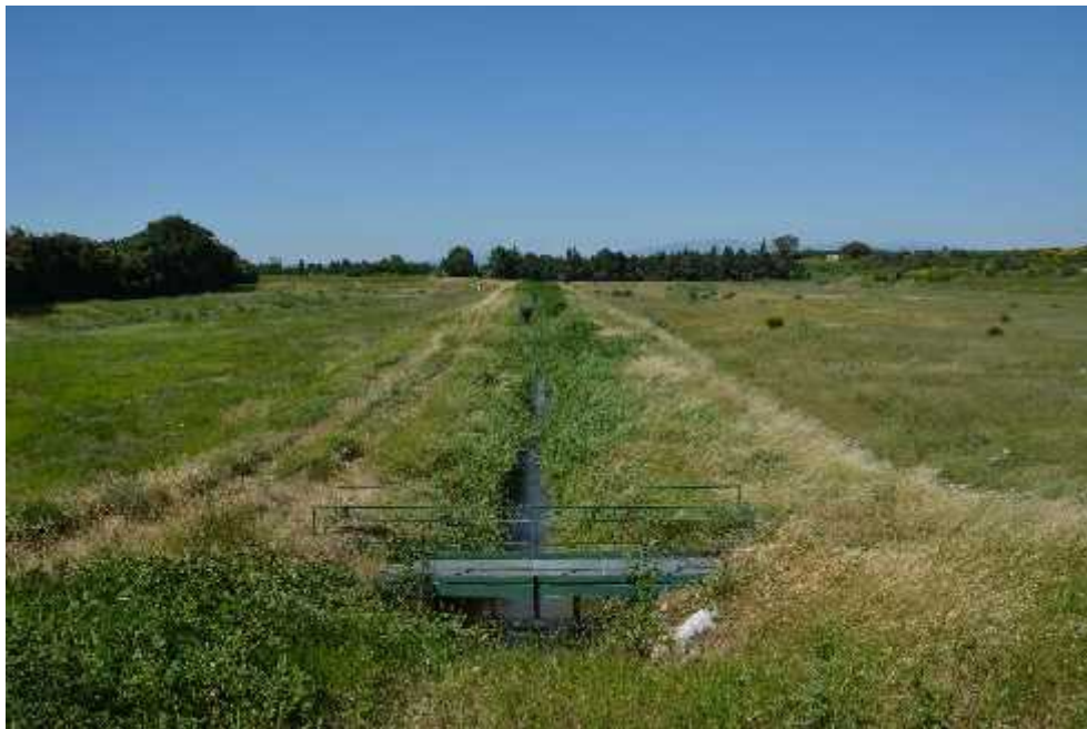
Bassin de rétention en amont de Sérignan
